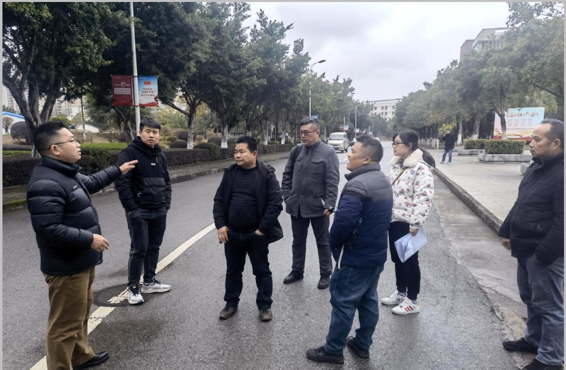
新建排污管工程开工实地考察
