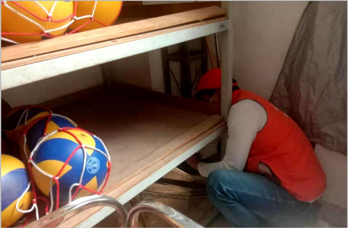
2月28日体育器材室发现白蚁，于当日进行处理
