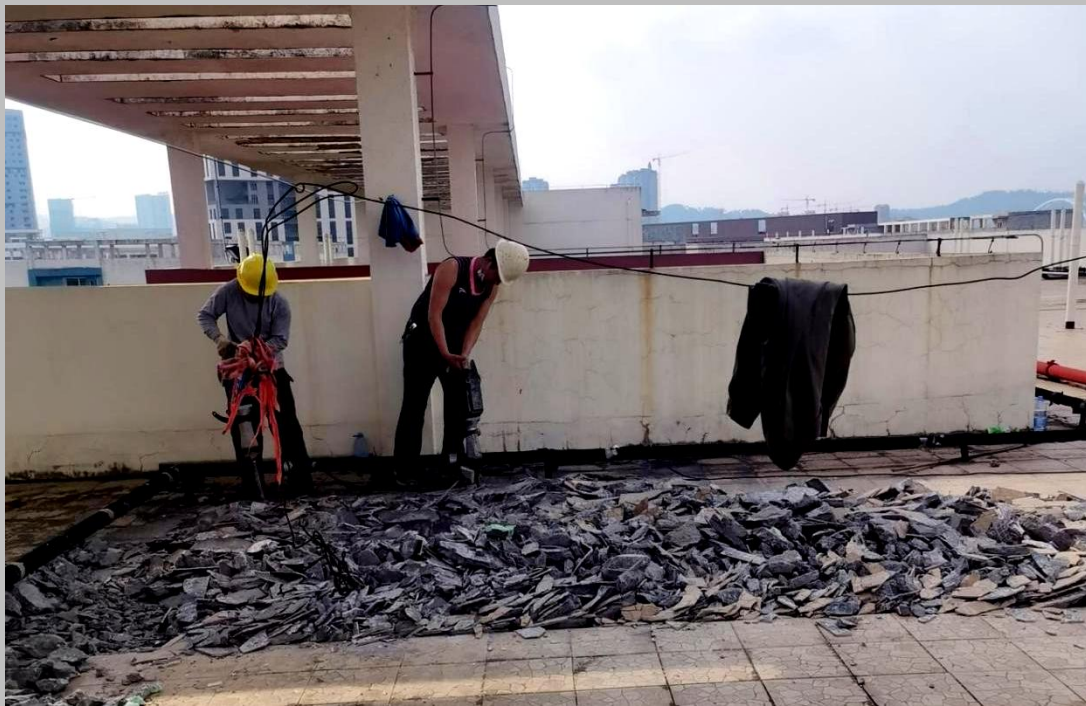
六栋学生宿舍屋面补漏，解决学生宿舍漏水问题
