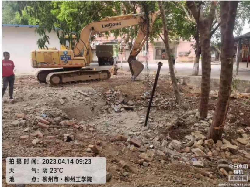
拆除一食堂东侧遗留的地面附着物现场
