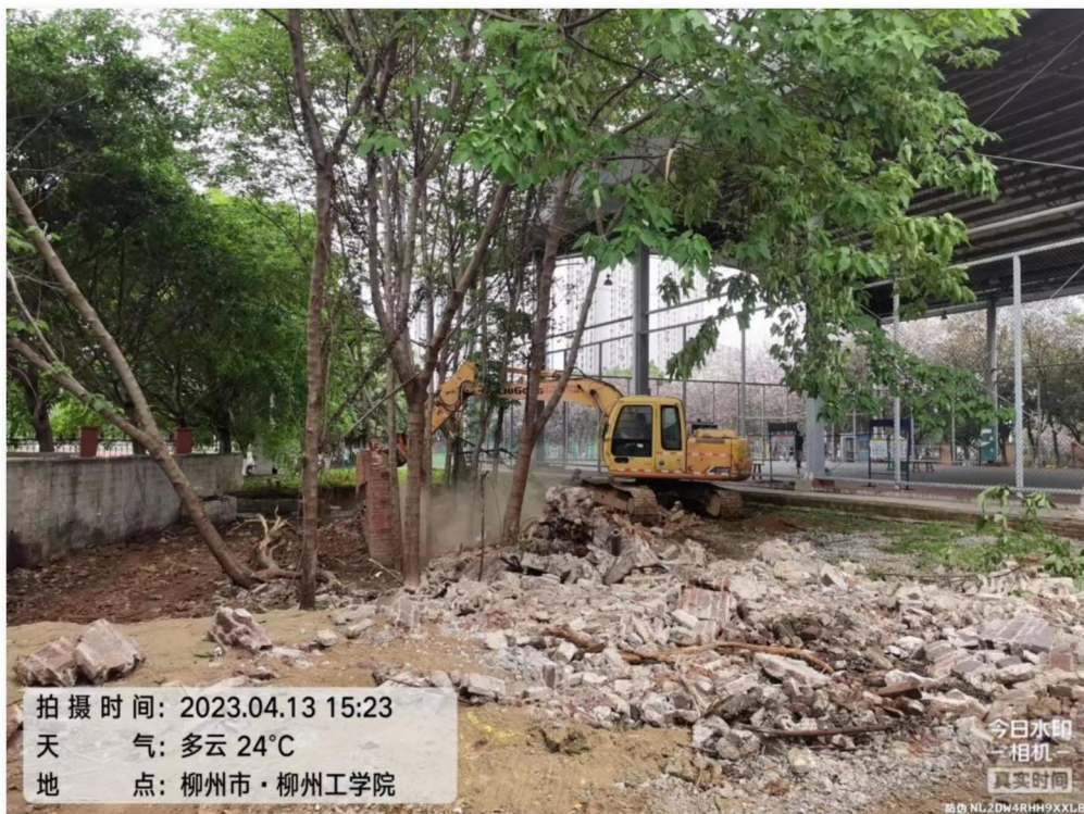
拆除一食堂东侧遗留的地面附着物
