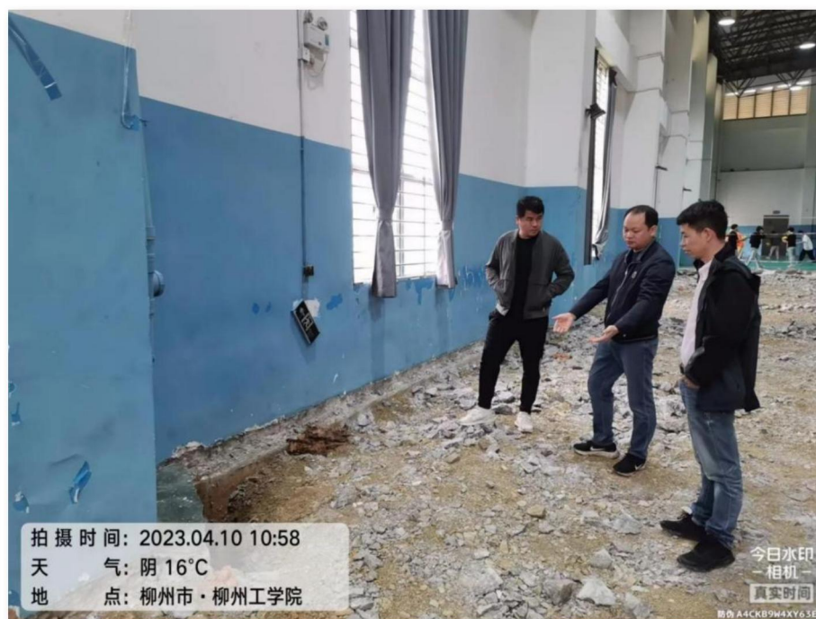
风雨操场沉降项目现场协调管理
